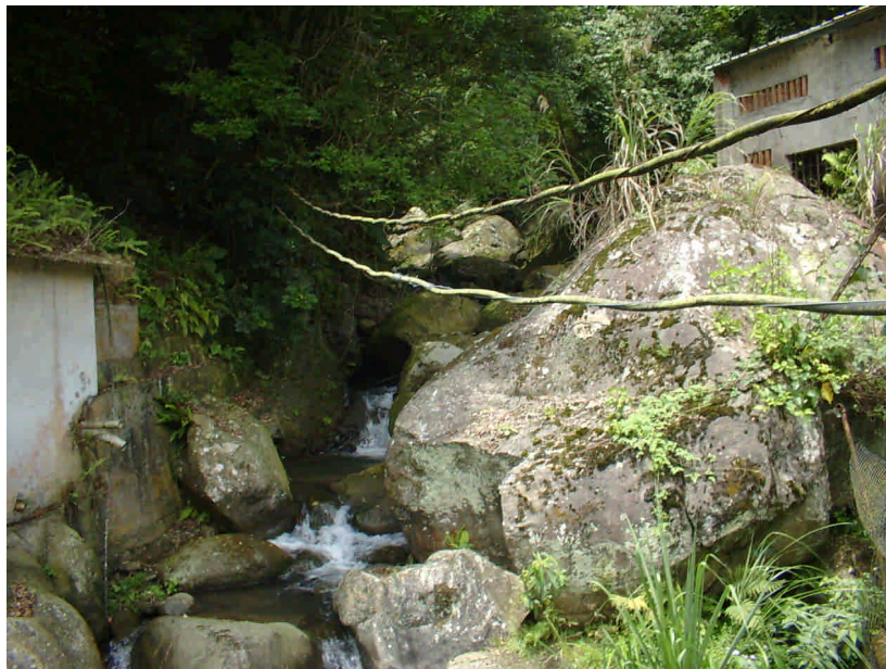
照片 9.1 土石流潛勢溪流新竹 A054 河床現況
